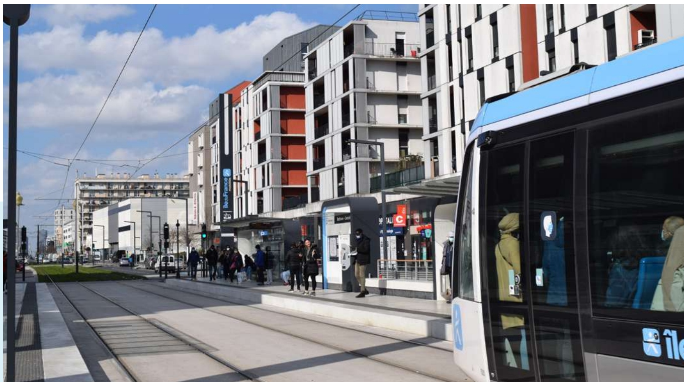
Arrêt du tramway T9 – Vitry-sur-Seine, Val-de-Marne
