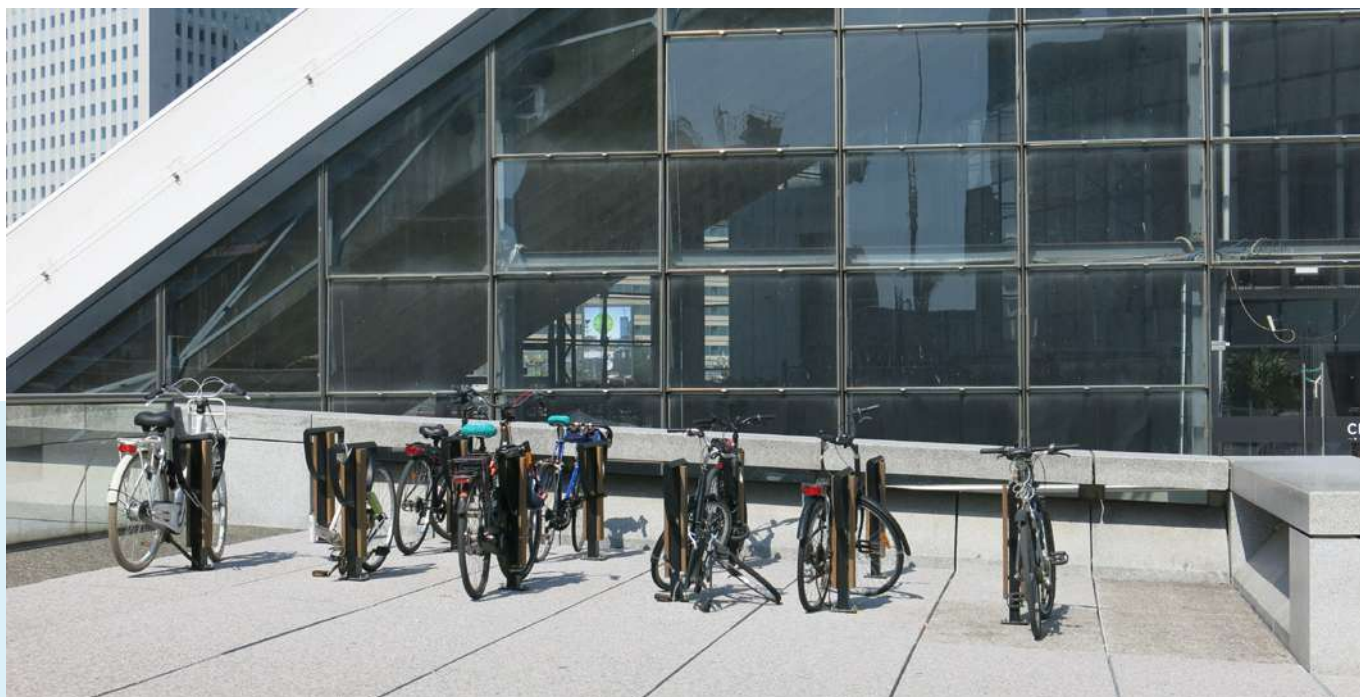
Parking à vélos au niveau du CNIT de La Défense, Hauts-de-Seine
