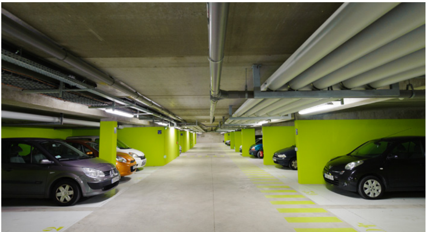
Parking souterrain au Pôle géosciences – Saint-Mandé, Val-de-Marne
