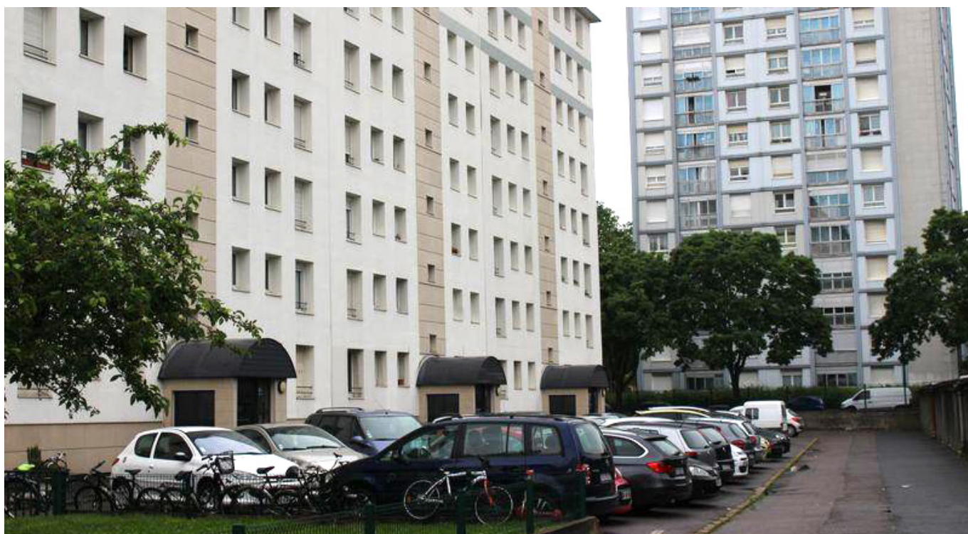
Parking dans un quartier d'habitat social – Gennevilliers, Hauts-de-Seine
