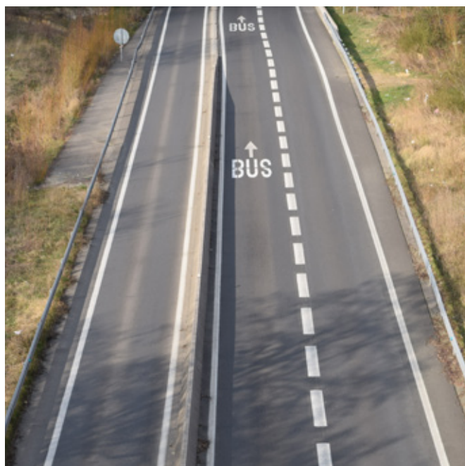
Voie réservée aux bus sur l'A10 – Essonne
