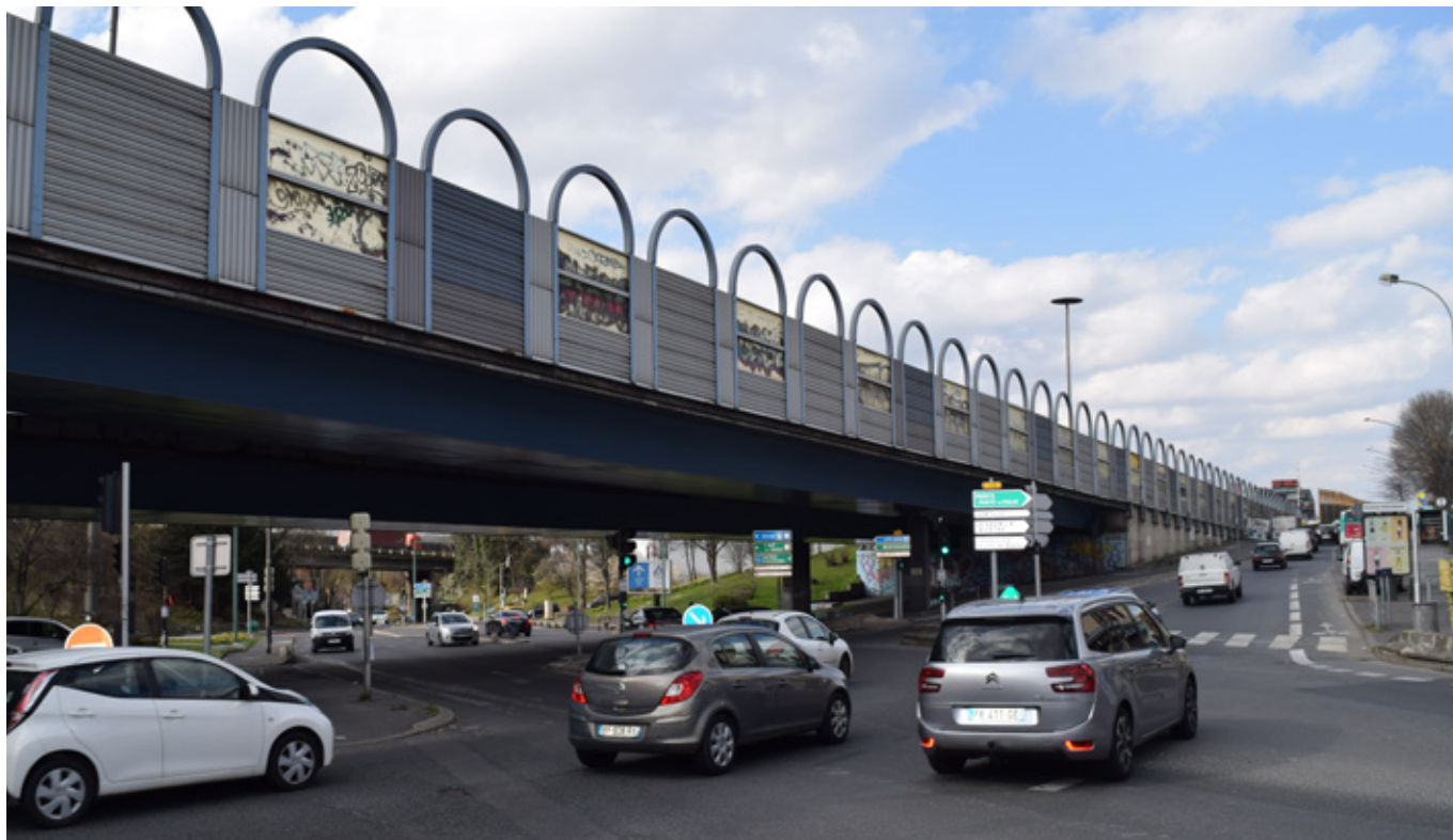
Autoroute A6 - Arcueil, Val-de-Marne
